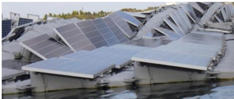
図 2-3 水上設置型太陽光発電設備の強風被害事例 (3)
