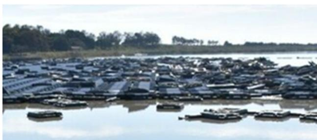
写真 2-1 水上設置型太陽光発電設備の強風被害事例 (1)
