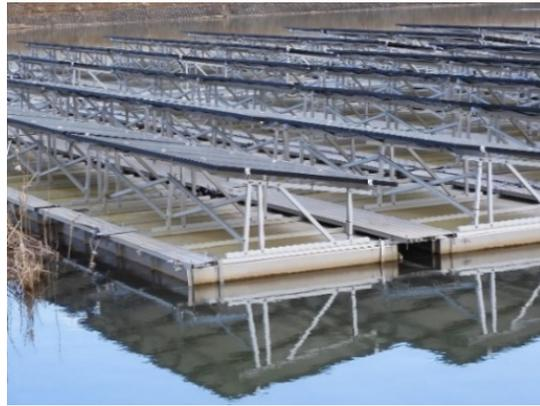
写真 7-2 大型フロートを用いたシステム
