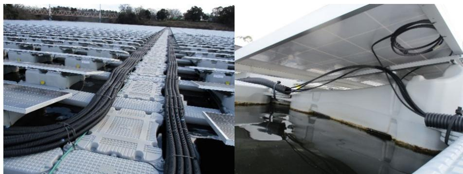
写真 12-2 配管に納めた配線の例
