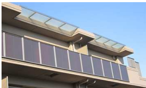
図 3-2-2 薄膜シリコン系の事例 カネカ 3-2-9)
