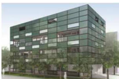
図 3-2-6 有機系太陽電池 (OPV) の 実証事例 大成建設 3-2-13)
