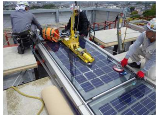
図 6-3-5 屋根 BIPV モジュールの取付施工の様子
