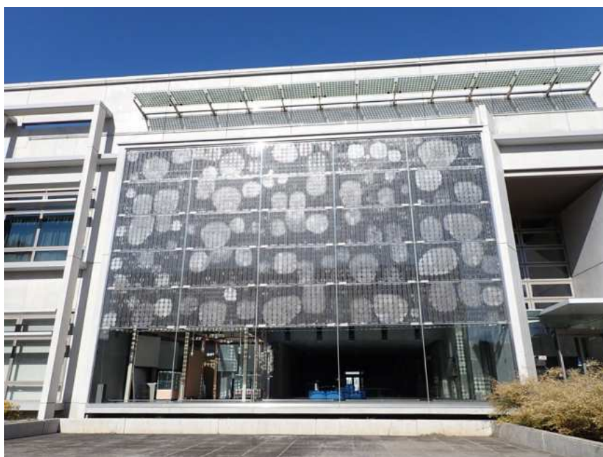
図 3-2-14 カーテンウォール型 BIPV で発生した不具合事例（デラミネーション）
