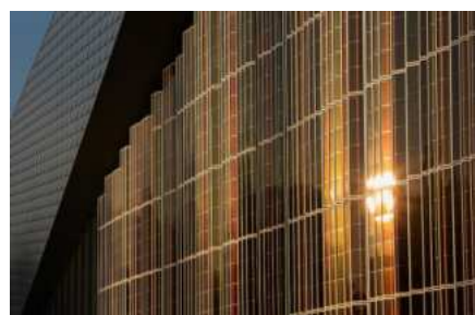
図 3-2-5 色素増感太陽電池 (DSSC) の 事例 EPFL 3-2-12)
