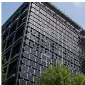
図 3-2-4 CIGS の設置事例 東工大 3-2-11)
