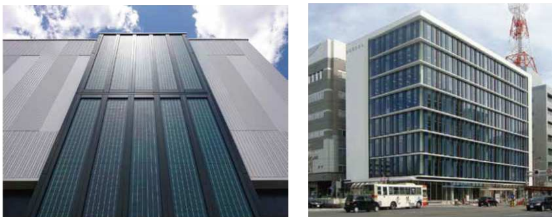
図 3-1-22 押出成形セメント板による BIPV モジュールの施工実績例 3-1-7)
