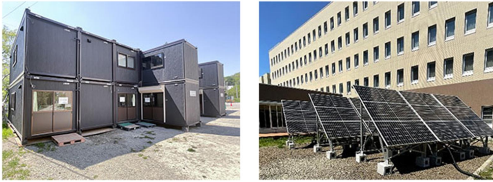
図 2-6 仮設現場事務所・太陽電池パネル
