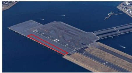
羽田空港D滑走路着陸帯 8 (舗装部)
