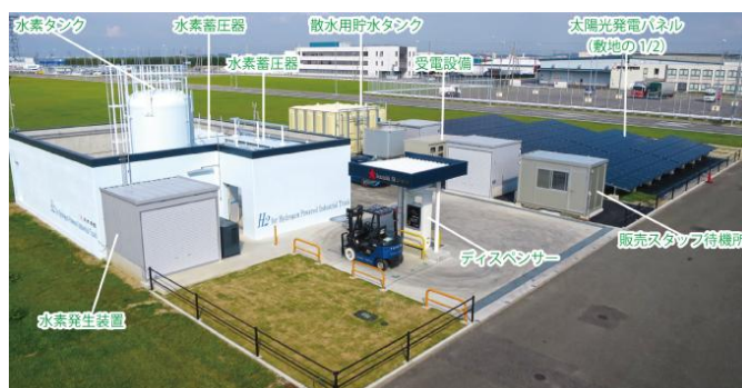
図 3-13 太陽光発電を用いたオンサイト方式水素ステーション例（中部国際空港）
